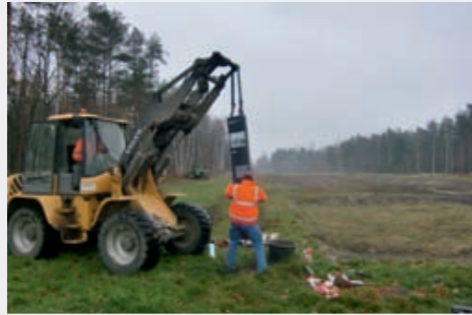
Einbau der Stelen auf dem Rasenkorrridor, November 2011 • Juliane Hummel/Stiftung niedersächsische Gedenkstätten
