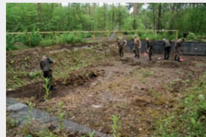
Arbeiten am ehemaligen Schwimmbecken der SS (Mai) * OstBtsm Klaus Langer, Verband der Reservisten der Deutschen Bundeswehr e.V., Kreis-gruppe Celle
