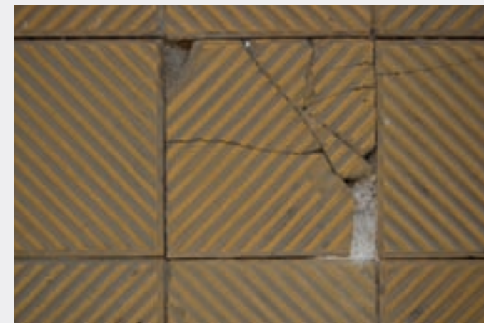
Der Fußboden im ehemaligen Hinrichtungsraum (Detail) • Stiftung niedersächsische Gedenkstätten
