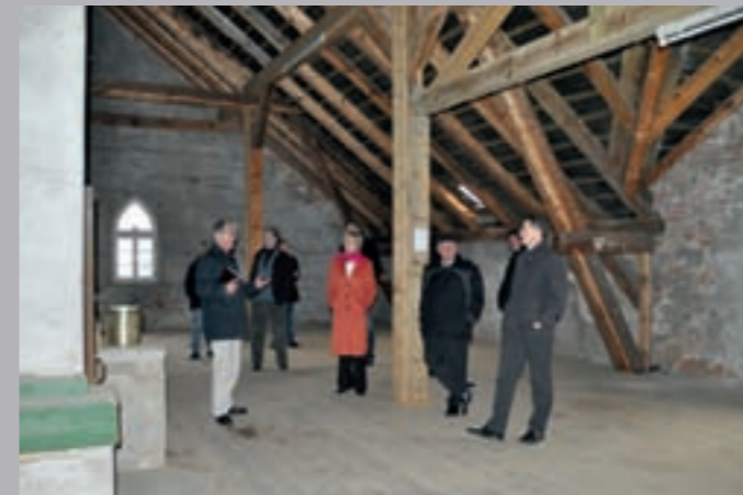
Das Torhaus beim Neuen Rathaus der Stadt Celle ist als Standort für ein Dokumentationszentrum zur Geschichte der Stadt im Nationalsozialismus im Gespräch. Zusammen mit Teilnehmern eines vorbereitenden Workshops nahm der Geschäftsführer der Stiftung am 21. Oktober an einer Ortsbegehung teil. • Stephanie Billib/Stiftung niedersächsische Gedenkstätten
