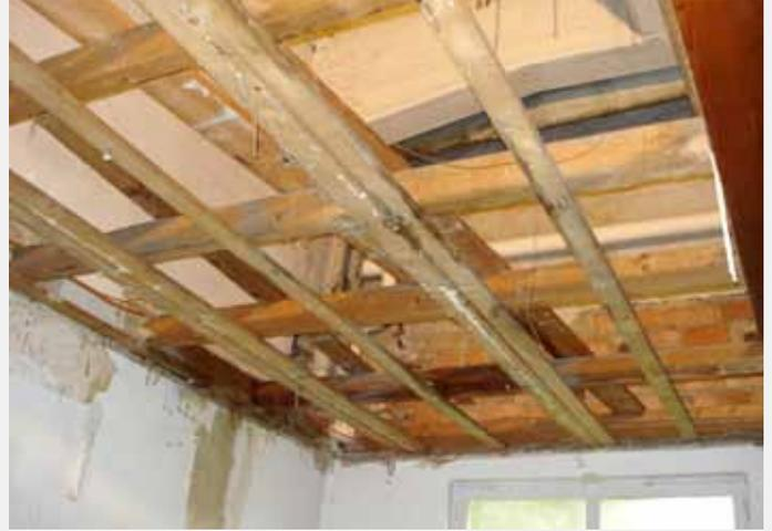
September: Als Folge eines erheblichen Wasserschadens musste im Seminarraum die Zwischendecke erneuert werden. Dabei wurde die ursprüngliche Raumkonstruktion unter der Hochstraße sichtbar. • AK Stadtgeschichte e.V.
