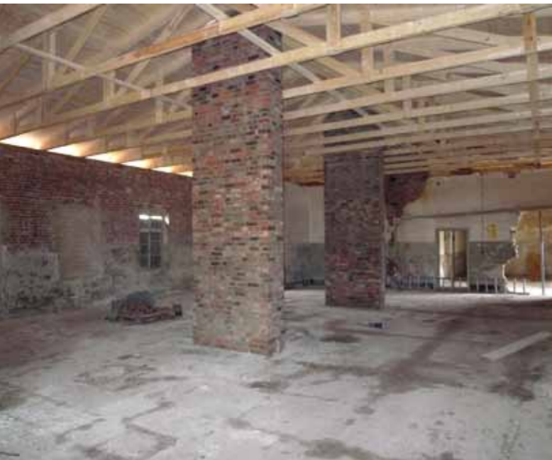
Blick in den Mitteltrakt der ehemaligen Lagerküche. Erkennbar sind die mit den gesäuberten Steinen wieder aufgemauerten Schonsteine und das neu errichtete Dach. Die Dachbinder entsprechen in ihrer Konstruktion den historischen Dachbindern. © Andreas Ehresmann
